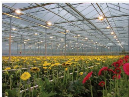
Рисунок 7 -Лампы ДНаТ в теплице подвешивают на значительной высоте
