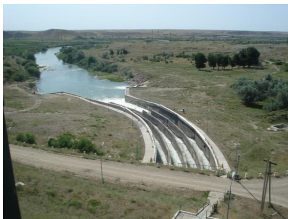
Рисунок 2- Водовыпуск - водосброс и водоотводящий лоток быстроток.
