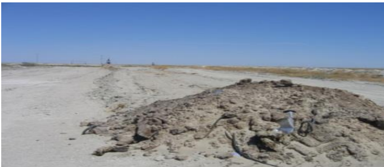
Рисунок 1 -Строительство внутрипромысловых дорог из замазученного грунта на месторождениях Арна Ойл
